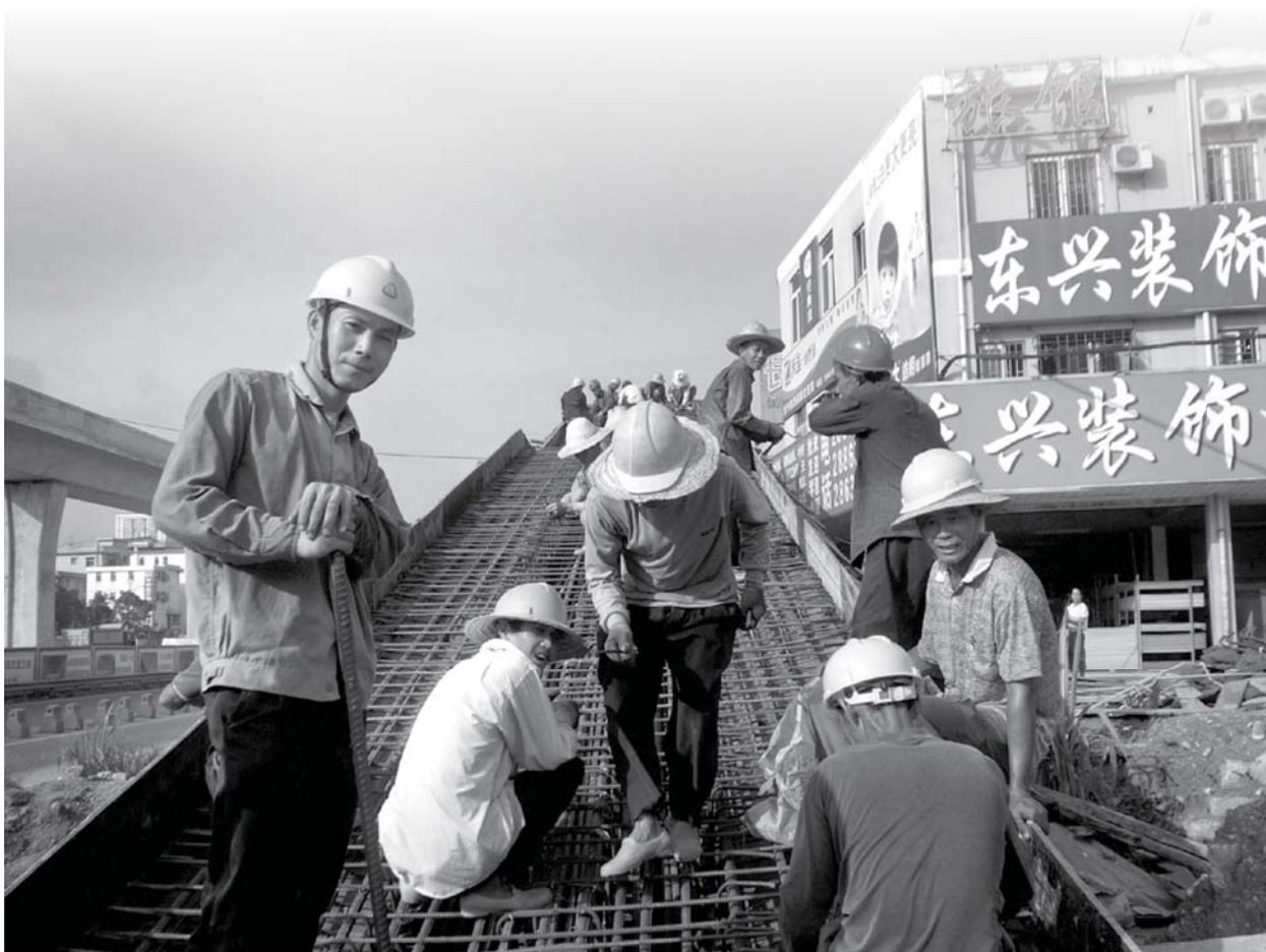
在深圳龍崗，由工人上班的工業區到繁華的商業中心，只有15分鐘的距離，建築工人在這段路上建造地鐵和天橋，連接兩個世界。（攝影：劉柳/基層色素攝影隊）
